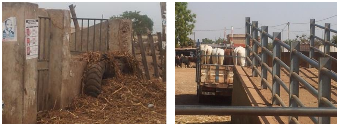
Fig. 5.– Exemple de couloirs de chargement et de déchargement d'animaux de rente bien entretenus et mal entretenus.
